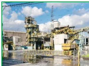
破碎・磁力選別・磨鉱・篩分 スラグ製品の品質作込
